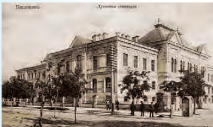
Clădirea principală a Seminarului Teologic din Chișinău, construită cu concursul mitropolitului Gavriil Bănulescu-Bodoni. A existat în anii 1817-1868, pe actuala stradă Mitropolit G. Bănulescu-Bodoni, vizavi de Grădina Publică din Chișinău.
